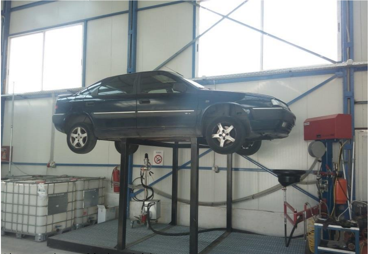
Ράμπα απορρύπανσης & λεκάνη ασφαλείας
